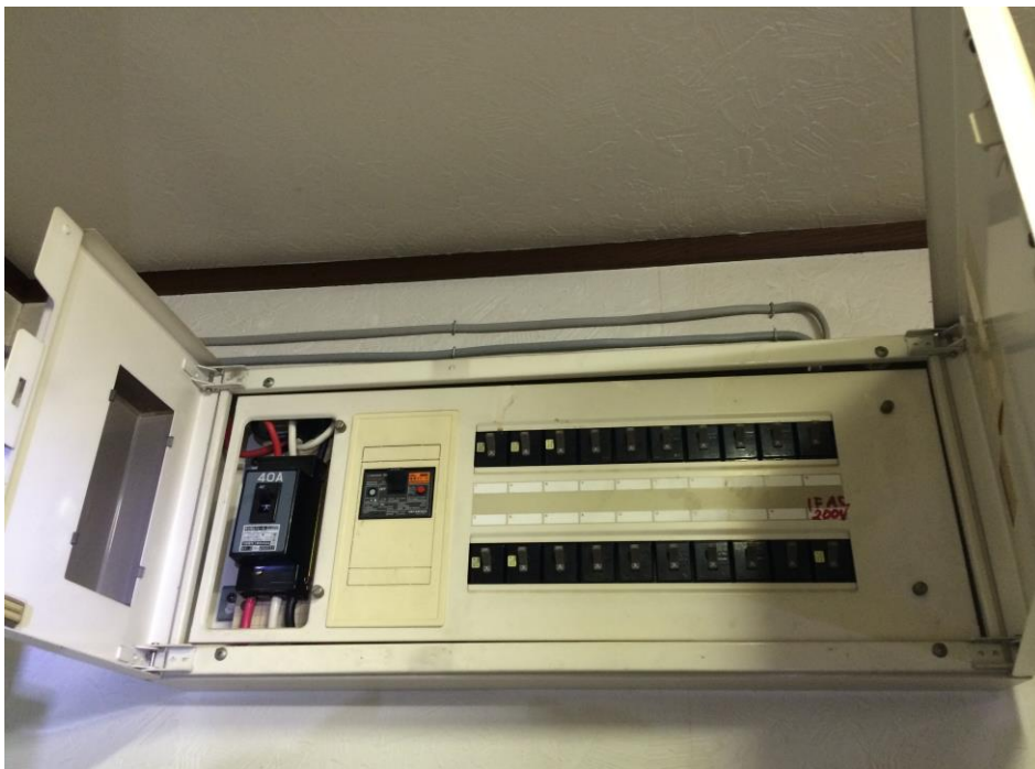
例② 金属製蓋観音開き分電盤
