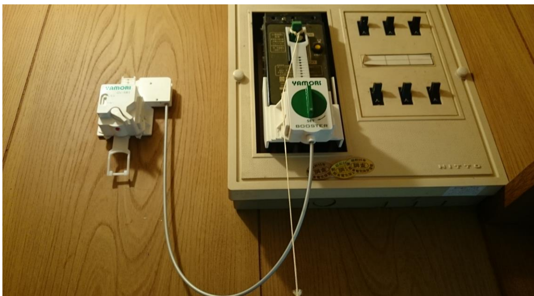
例③ ブレーカースイッチ下 (専用補助板にて取り付け)
